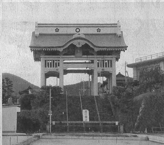
熊本地震で被災し、約2億5千万円をかけて修復する仁王門が決まった本妙寺の仁王門 11月、熊本市西区
