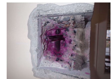
★柱の健全度調査★
