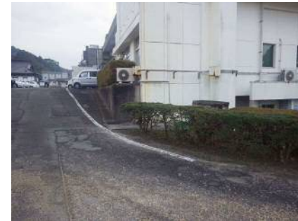
★敷地内の高低差★
