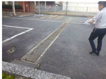
★外構撤去範囲調査★
