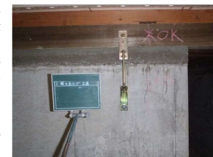
★土台上げによる沈下修正★
