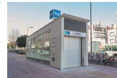
★東京メトロ防水シャッター閉鎖後★
