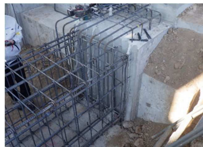
★基礎配筋の様子(2)★
