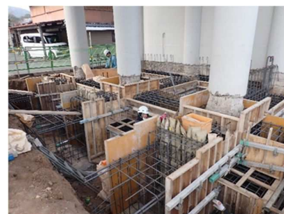
★基礎配筋の様子(1)★
