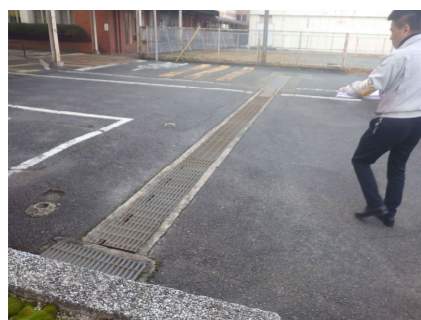
★外構撤去範囲調査★
