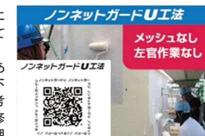
に工期が短縮できる「ノンネットガードU工法」を新たに提案しています。左官工が必要なく、防水(塗装)工で施工が可能であり、特殊アンカーを用いて高強度1成分形ウレタン樹脂にて外壁面を全面被膜し、将来的な剥落の懸念を払拭できる新発想の工期短縮・省人化型の予防保全剥落防止工法です。」
