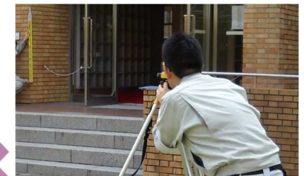
★建物基礎の傾斜調査★
