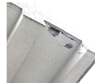
★庇裏の鉄筋さびによるコンクリート剥落★
