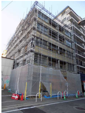
★足場を組んだところ★
