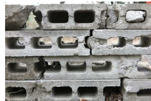
★老朽化したブロック★
