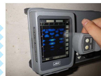
★コンクリートの中の鉄筋確認★ (緑部分が鉄筋があることを示しています)
