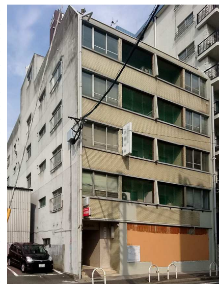
★この建物を改修します★
