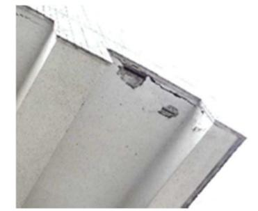
★庇裏の鉄筋さびによるコンクリート剥落★
