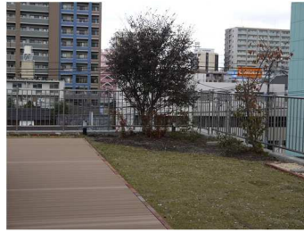
★改修後の屋上★
