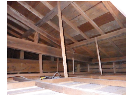
★小屋組みの様子★
