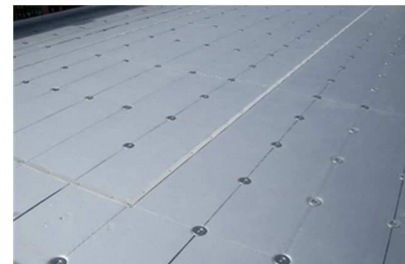
★Zルーフハイブリッド工法(施工例)★
