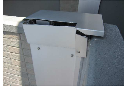
★地震により損傷したエキスパンションジョイント★
