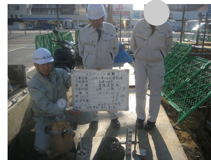
★生コン打設時検査★
