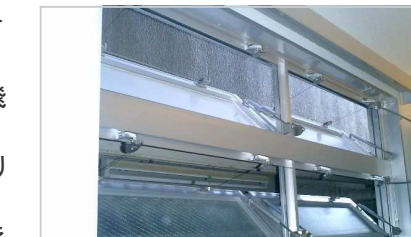
★排煙設備の例(窓)★
