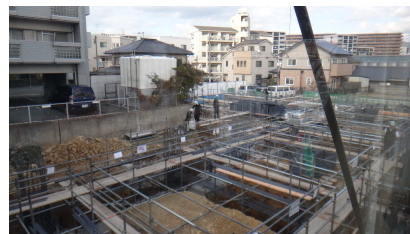
★基礎の配筋状況★
