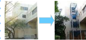
★エレベーターの新設★
