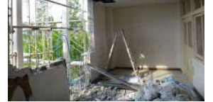
★既存壁の撤去★
