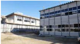
★既存校舎(左)と仮設校舎(右)★
