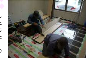
★施工中の写真。床を剥いで設置★
