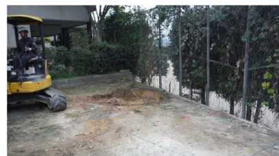
★地盤改良も行い安全・安心な建物へ★
