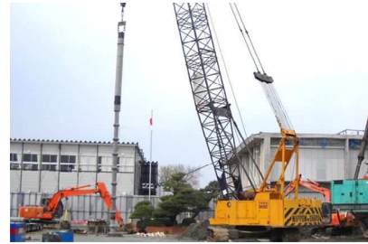
★既製杭の施工状況★
