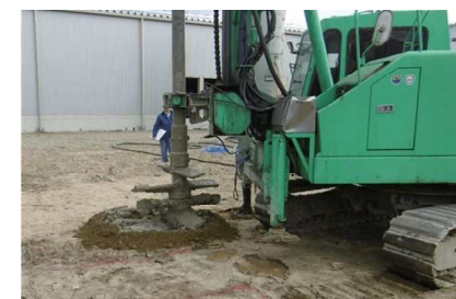
★地盤改良杭の施工状況★
