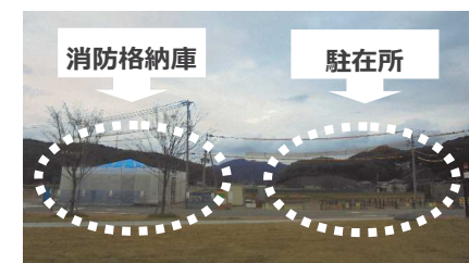
★現在の工事の様子★ 格納庫と駐在所の場所が入り替わります
