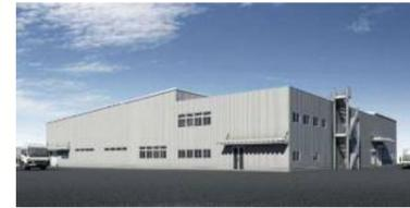
本計画は広大な敷地に点在している生産工場を一箇所に集約させることで、既存建物の老朽化対策と、食品工場としての衛生面・機能面の強化に取り組んだ事業計画です。鉄骨造一部2階建、縦横の長さは45m×45m、延床面積は2,300㎡強の規模で、弊社では意匠と構造の設計監理業務に携わせて頂きました。工事を進めるにあたって必要な実施設計の作図や行政対応に追われる日々が続いていましたが、無事に着工することができ、一安心しています。
