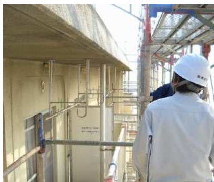
☞長期修繕計画に基づく改修工事のひとつ。頭を打たないようにね！
