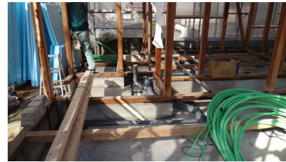
★床下配管工事★
