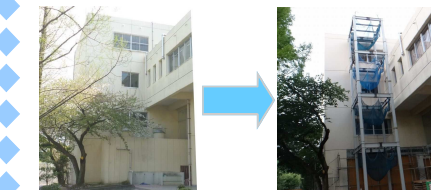
★エレベーターの新設★
