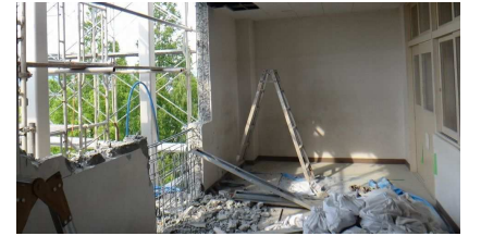
★既存壁の撤去★
