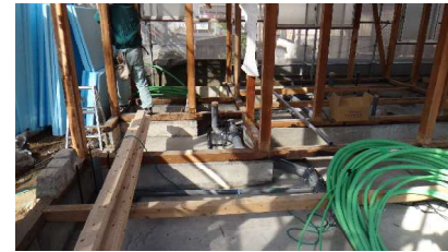
★床下配管工事★
